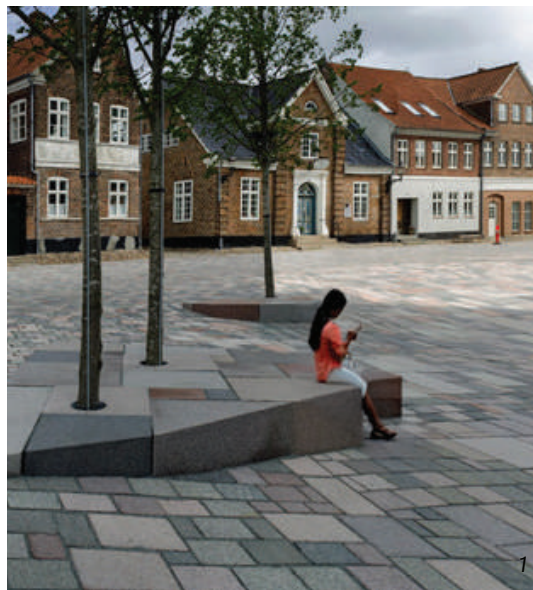
Belægningen rejser sig for at blive til en uformel siddekant.
